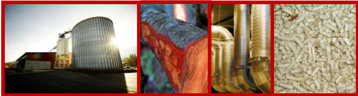
Hallingdal Trepellets : l'usine ; la matière première; les tuyaux du circuit de chaleur entre l'usine d'incinération et l'usine de Trepellets ; des granulés de bois (source : Bård Strige Øyen, Gulbrand Gulsvik).
