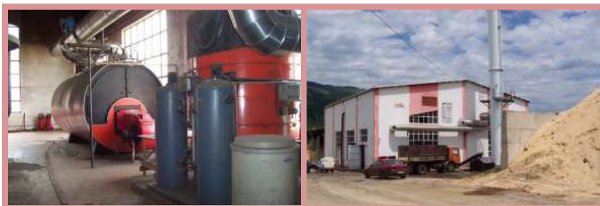
Centrale thermique fonctionnant à la sciure servant à alimenter un réseau de chaleur local à Vatra Dornei en Roumanie
